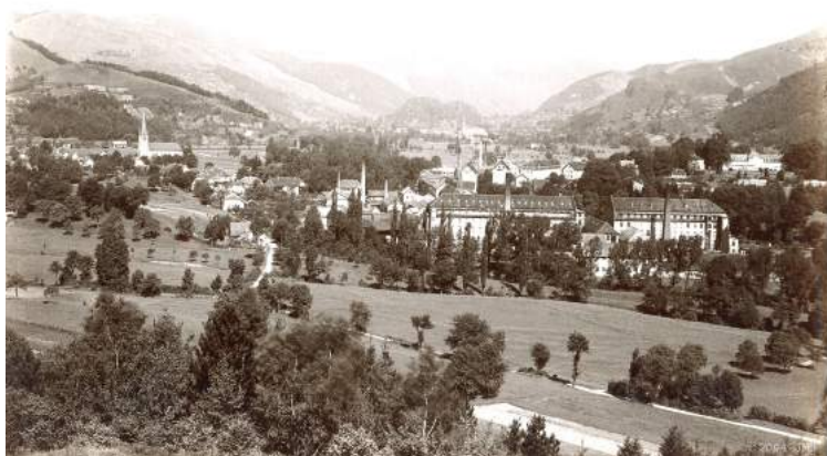
Vue du site de Wesserling vers 1900
